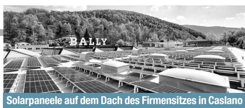
Solarpaneele auf dem Dach des Firmensitzes in Caslano
